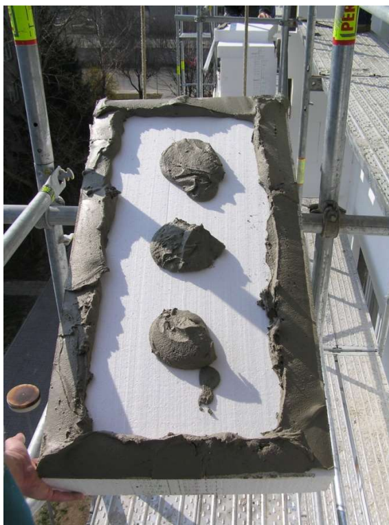
Obr. 4: Nanášení lepicí hmoty pomocí obvodového pásu
